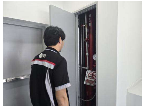
รูปที่ 3.1-22 ตรวจสอบรอยรั่วของท่อจ่ายน้ำ และท่อระบายน้ำ
