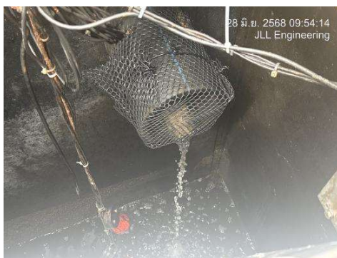
รูปที่ 3.1-8 ติดตั้งตะแกรงดักมูลฝอยที่บ่อบำบัดน้ำสุดท้าย
